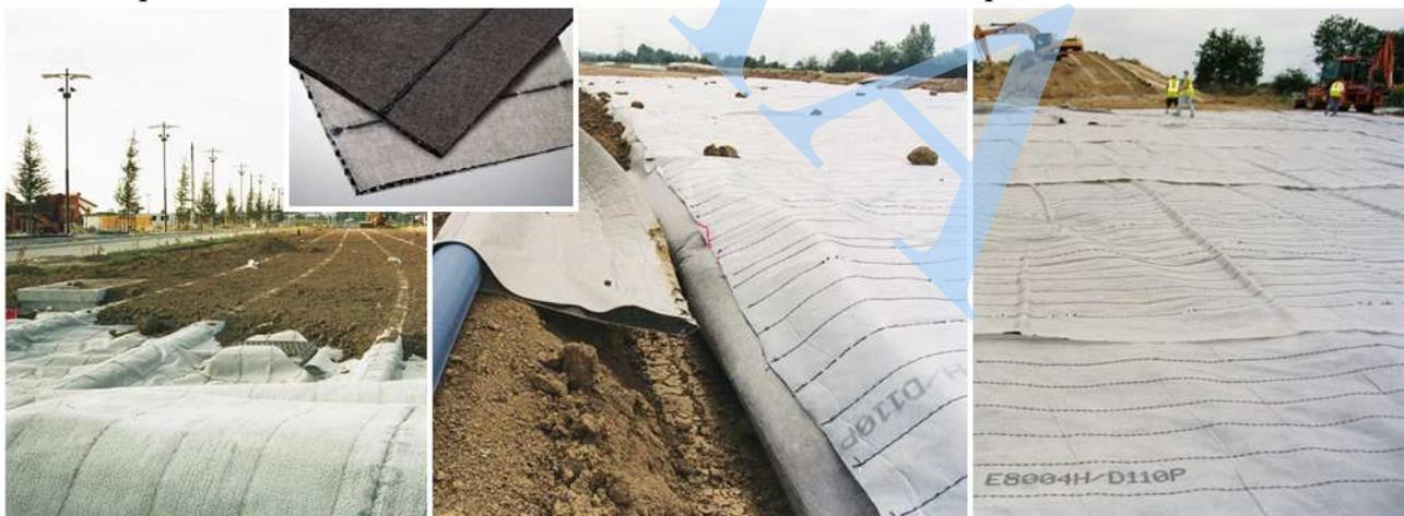
Госетки — материалы, также состоящие из открытых ячеек, однако поскольку эти материалы имеют невысокую прочность при достаточно больших относительных удлинениях, они не являются армирующими элементами, а выполняют роль защиты откоса земляного полотна от эрозии.
