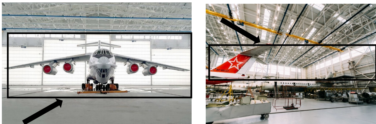
Рисунок 1 – Ангар ОАО «Минский завод гражданской авиации № 407»: а) – светопрозрачные, теплосберегающие ворота [3]; б) – светопрозрачные панели [1]
